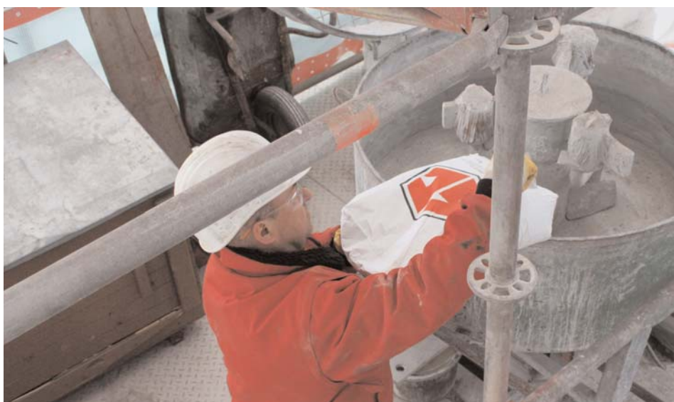
Die Verschleißschutzmasse WearStop wird in einem Mischer angerührt und manuell mit Kelle und Glätter aufgetragen. (Foto: wed)
