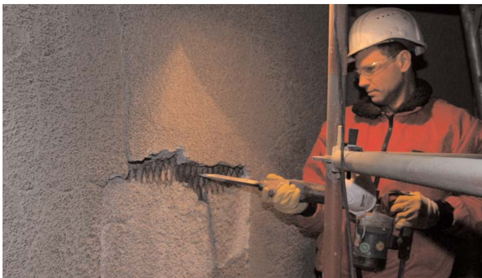
Individuelle und fachgerechte Prüfung und ggf. Reparatur der Beschichtung sichert dem Betreiber eine störungsfreie Produktionszeit. (Foto: wed)
